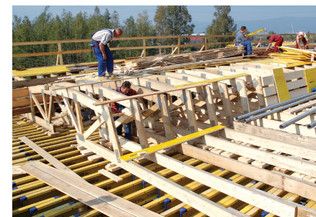
> Bednění dálničního mostu, Trmice-Knínice
